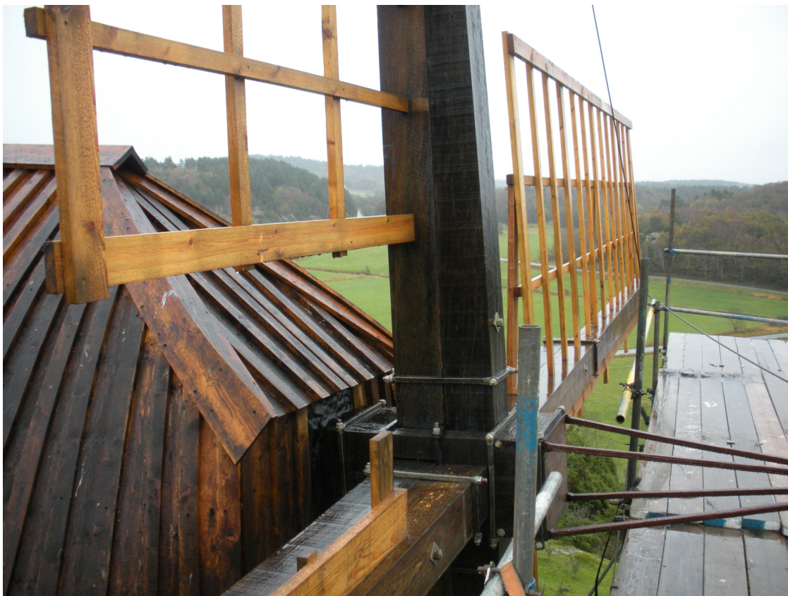
De nya vingarna, monterade på den nya axeln och mittkorset.
